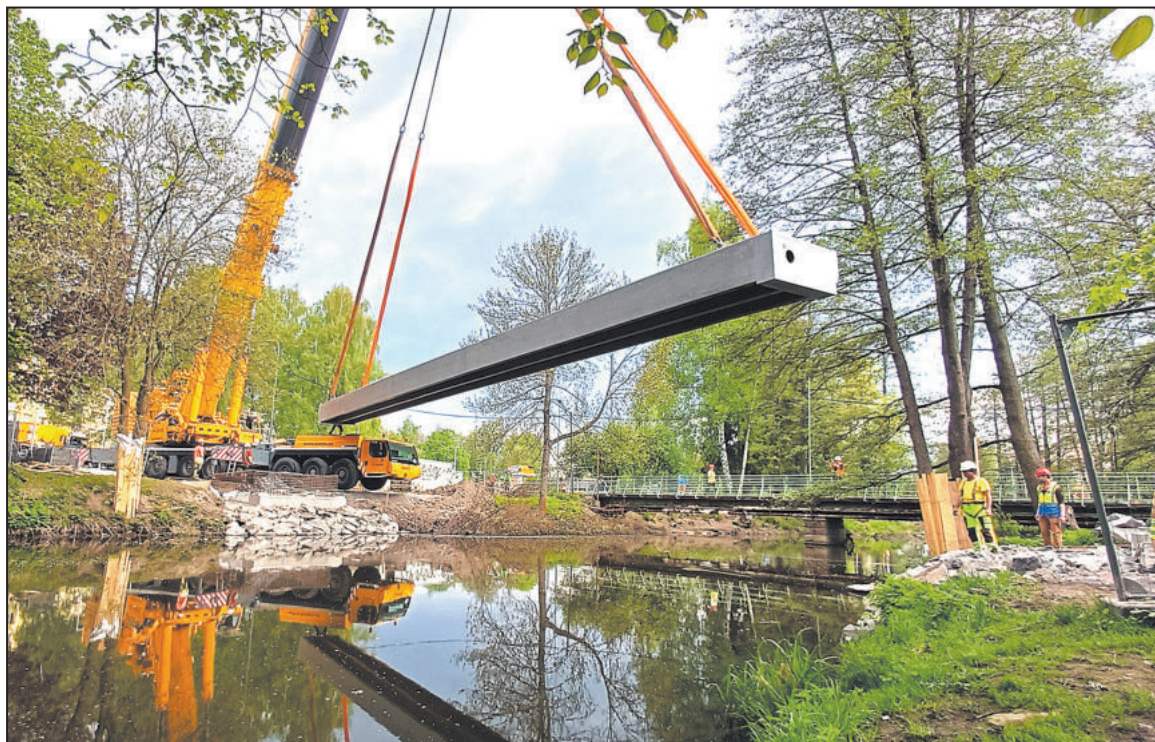
POKLÁDÁNÍ mostu bylo pro Žďáráky mimořádnou podívanou.
