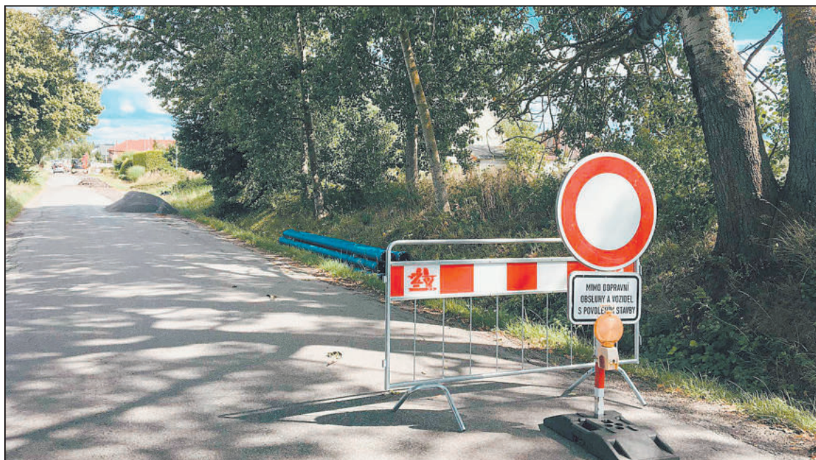
UZAVŘENÁ ulice Rantířovská, pohled při vjezdu do Jihlavy. Foto: -lb-
