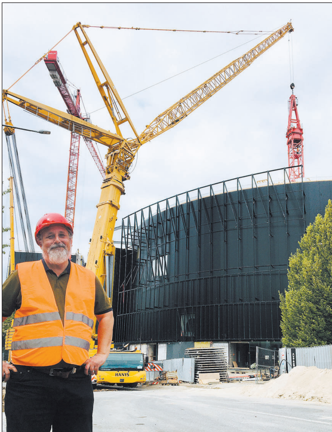
ODBORNÝ jeřábový technik Petr Winkler z firmy Wolffkran Lokus dohlížel v týdnu po Velikonocích na demontáž tří z pěti věžových jeřábů, které zajišťovaly více než rok stavbu HMA.
