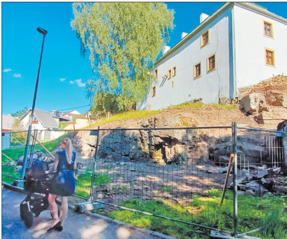
MÍSTO pod skálou v ulici Nábřežní, kde při rekonstrukci lokality Tvrz vznikne parkoviště.
