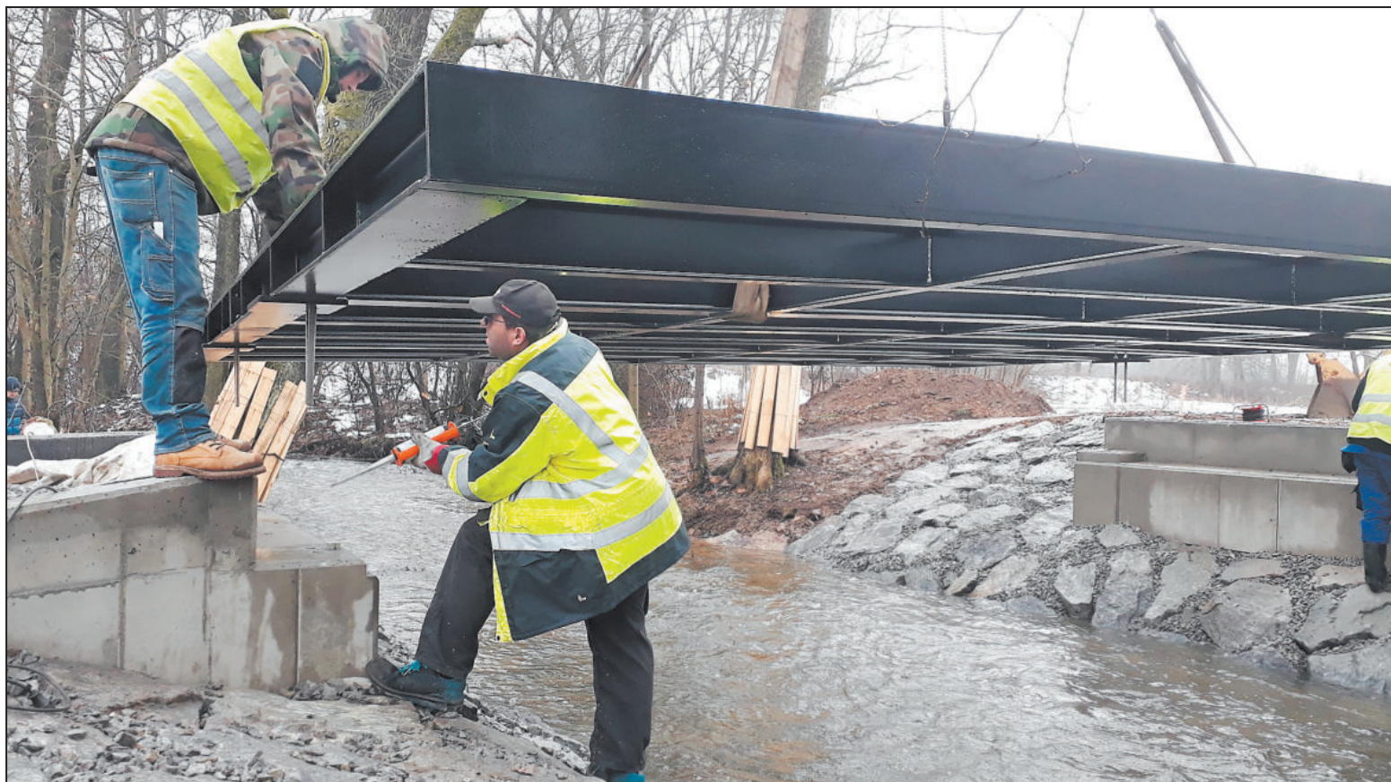
INSTALACE lávky Táferna proběhla hladce. Souhra těžké techniky a lidské dovednosti byla rychlá.
