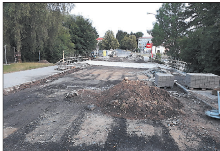
MOST přes řeku Sázavu ve Strojírenské ulici prochází velkou opravou.
