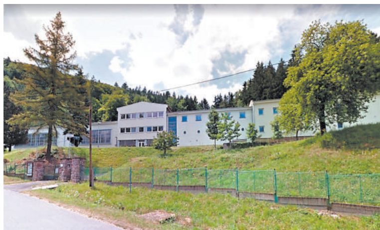
ÚPRAVNA VODY Vír slouží více než 60 let.
