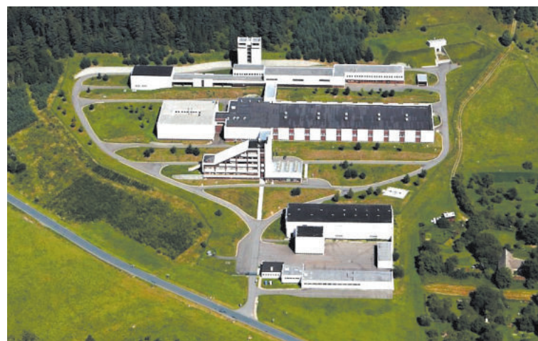
ÚPRAVNA VODY Švařec v Koroužném.
