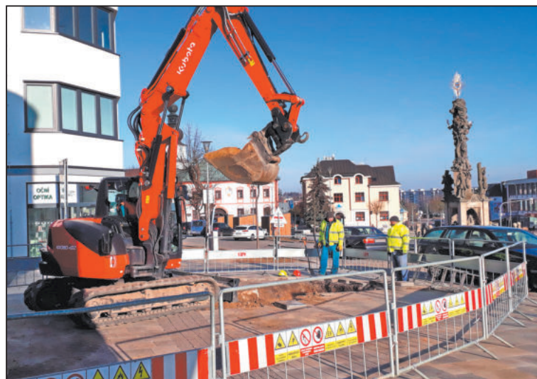
NA PĚŠÍ ZÓNĚ se stavaři opět po zimní přestávce vrátili do výkopů. Do srpna má být promenáda hotová.
