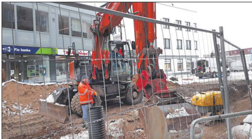
S JAREM se vrátí stavební ruch na pěší zónu. Za sebou má rekonstrukci podzemních sítí a nyní tato část Nádražní ulice dostane moderní povrchy, mobiliář i vzrostlé stromy. Foto: lenka Kopčáková
