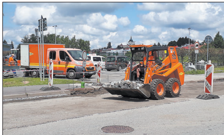
STAVEBNÍ ruch na Jungmannově ulici. Z parkoviště před stadionem je přechodně sklad materiálu a techniky. Foto: Lenka Kopčáková
