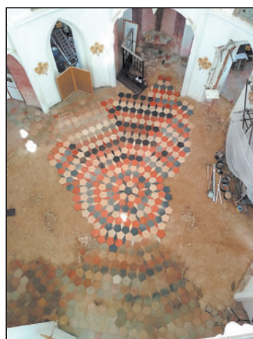
ČÁST podlahy složená do obrazců zatím na zkoušku. V popředí zlomek původní „vybledlé“ historické dlažby. Vzdálenější mozaika je již dobarvená
