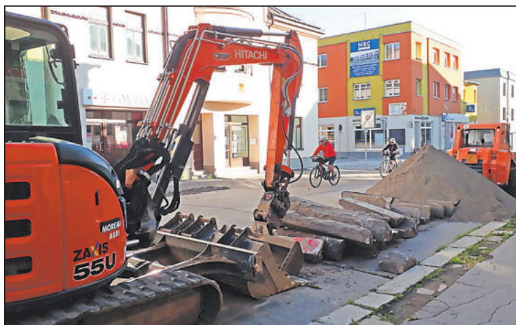
V ZAČÁTKU rekonstrukce pěší zóny bylo nutné odstranit obrubníky chodníků a připravit terén pro výkopové práce.
