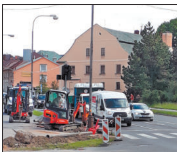
OSAZENÍ nových semaforů si vyžádalo i zemní práce.
