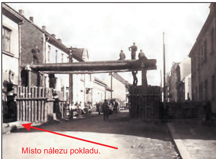
PŘI STAVĚNÍ zátarasu proti tankům dělníci u sklepního okénka Lengsfeldova domu objevili poklad. Německý dozorce jej ihned zabavil. Foto: archiv V. K.
