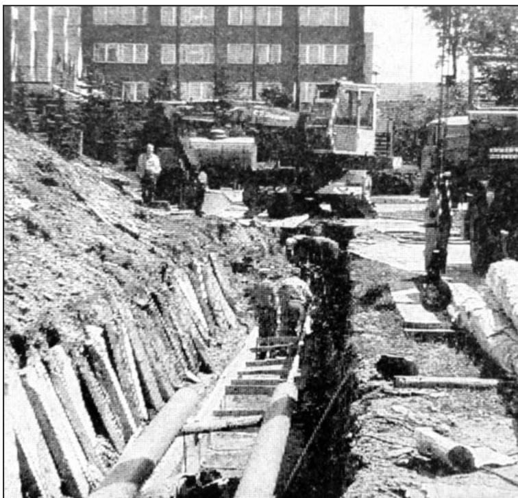
REKONSTRUKCE křižovatky v Dolní ulici.
