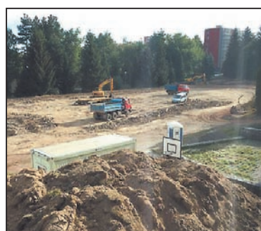
NA ŠKOLNÍM hřišti ZŠ Švermova běží čilý stavební ruch. Výsledkem bude moderní sportovní areál.
