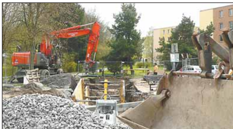
OPRAVÁM povrchů ulic mnohdy předchází i modernizace podzemních sítí. Jako např. letos na jaře v ulici Strojírenská. Ilustrační foto: Lenka Kopčáková
