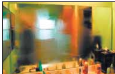
OROSNÍ studených ploch (zrcadel) krátce po zapnutí spotřebiče.
