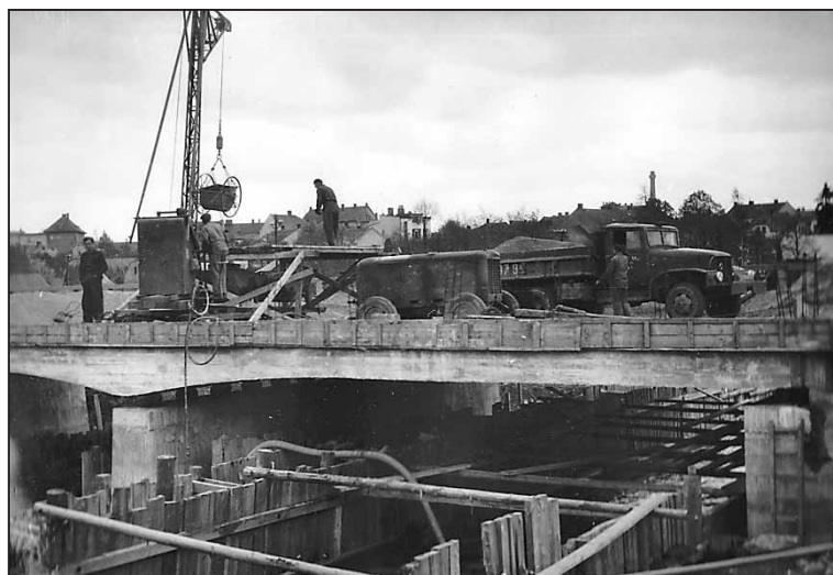
STAVBA silničního mostu, který koncem 50. let min. stol. spojil Stalingrad s městem.
