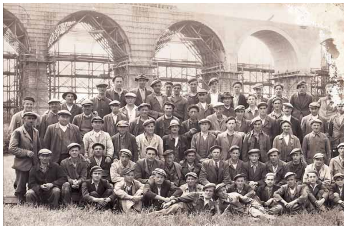
PARTA barabů pracujících na žďárském viaduktu a snímek na památku před hotovým dílem. Rok 1942.
