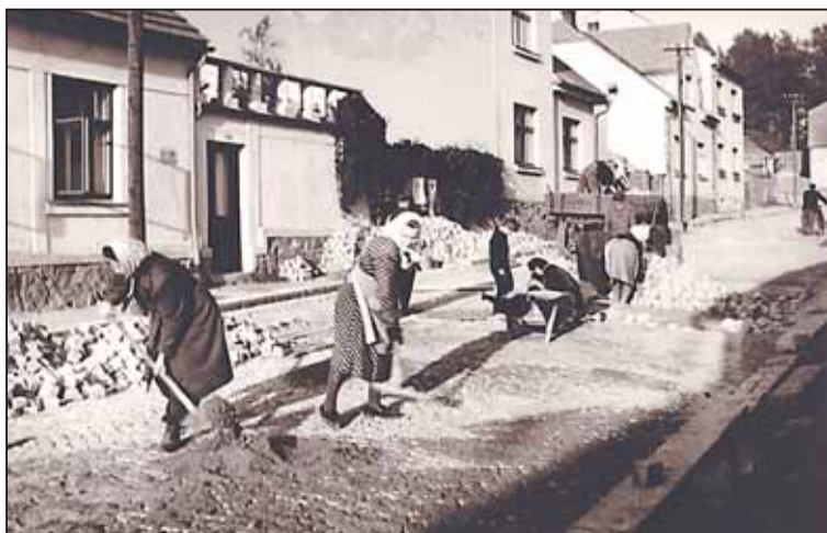
DLÁŽDĚNÍ jak probíhalo na Smetanově ulici v roce 1963. První zleva paní Lysá, žena zvěrolékaře před svým domem.
