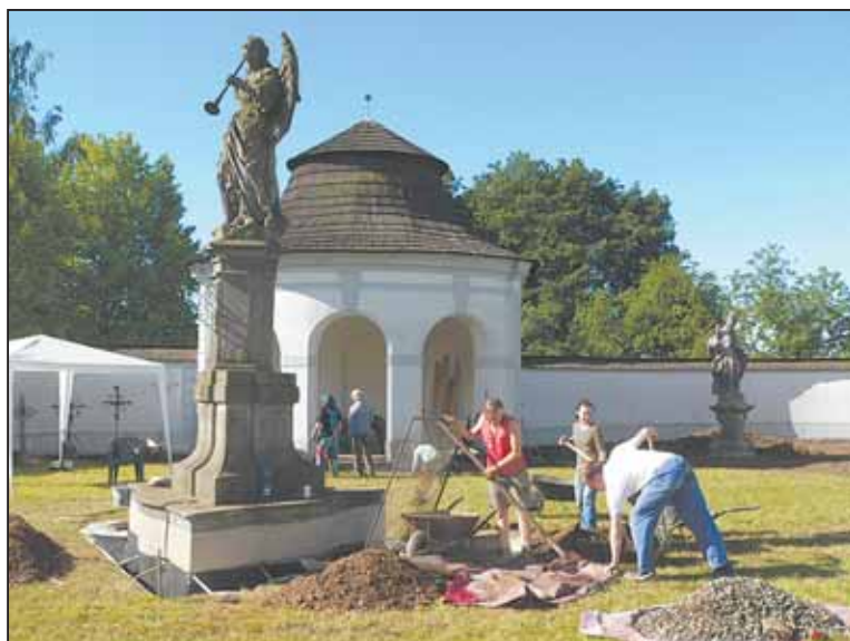
PARTA dobrovolníků z Anglie a Čech se v červnu pustila do terénních úprav Dolního Santiniho hřbitova.
