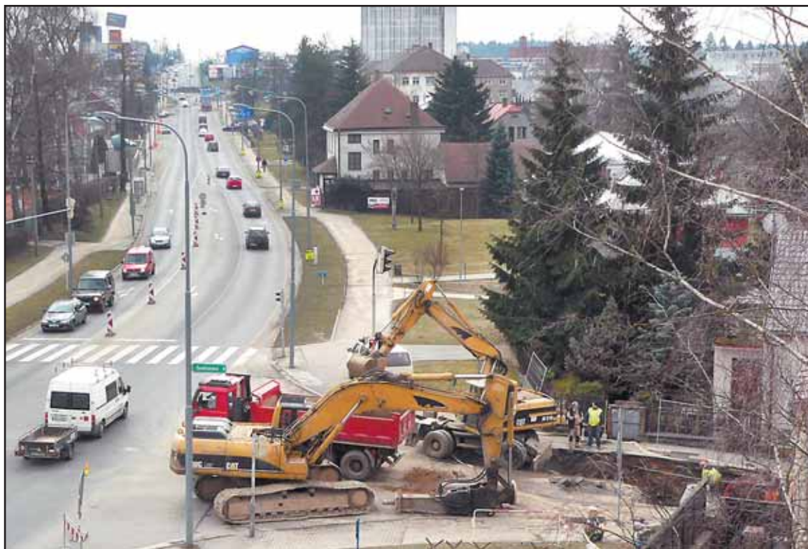
STAVEBNÍ ruch na začátku ulice Smetanova, jak probíhal v měsíci březnu. Po rekonstrukci kanalizace přijdou na řadu nové povrchy. Lidé, z rok odstavené ulice, poslali na radnici petici. Více na str. 2.
