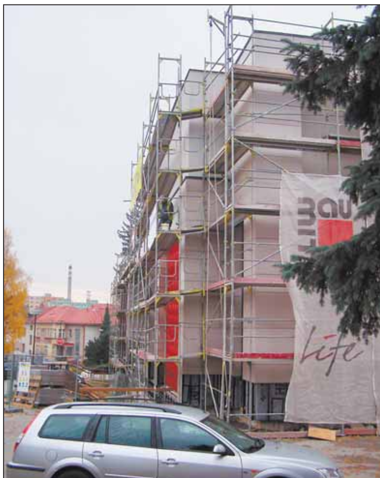
ZATEPLENÍ divadla částečně komplikovalo jeho provoz.
