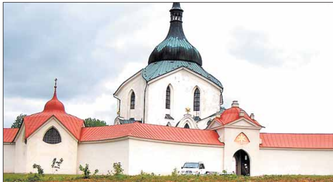
V KOSTELE sv. Jana Nepomuckého na Zelené hoře se musí opravit část krovů.
