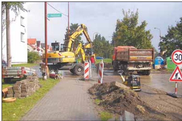
VE ŽĎÁŘE NAD SÁZAVOU se nepracuje pilně jen ve středu města, ale úpravy procházejí také některé ulice. Foto: Antonín Zvěřina
