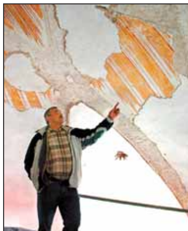
Z LEŠENÍ ukazuje detaily stropu kastelán Karel Straka (rok 2006). Foto: archiv
