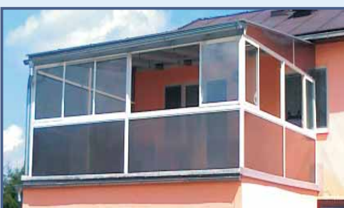
lodžie, balkony a pergoly
