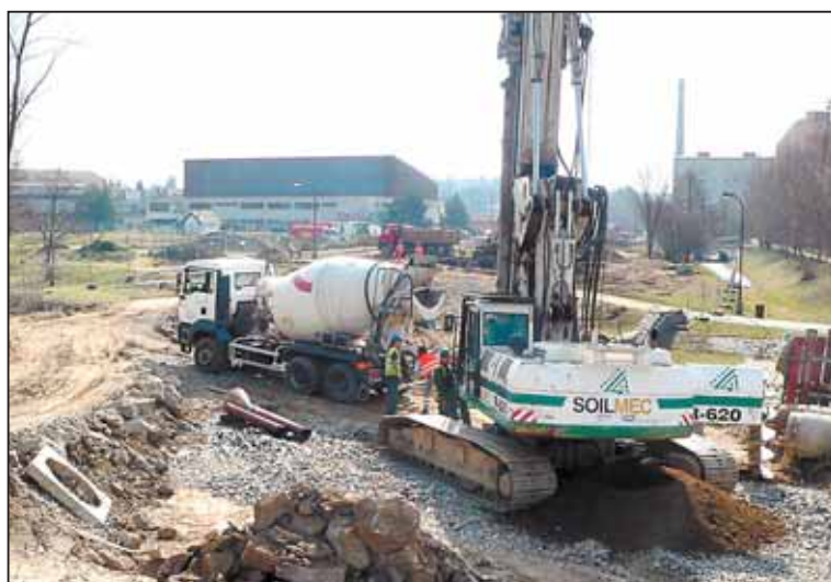
DUBEN 2013 a vrtání pilotů pro budoucí most přes údolí Sázy.
