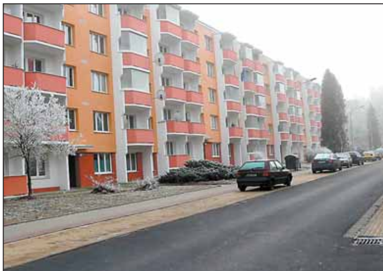
OPRAVENÁ ulice Bří Čapků má nyní i dost míst na parkování.
