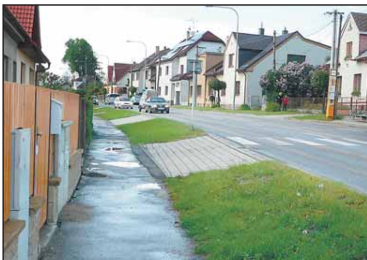
BEZRUČOVA ulice volá po nových chodnících. Oprava začne od barokního mostu. Foto: Lenka Kopčáková
