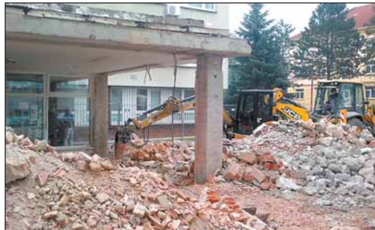
BOURACÍMI pracemi v pátek 24. 5. začala rekonstrukce bufetu v městském zdravotnickém zařízení. Dokončení celé stavby se předpokládá na konec července a samotné otevření pak v průběhu měsíce srpna.
