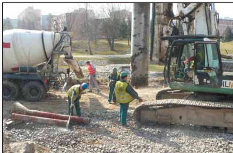
STAVBA třípolového mostu na Klafar již začala. Těžká technika na snímku hloubí piloty. Foto: Lenka Kopčáková
