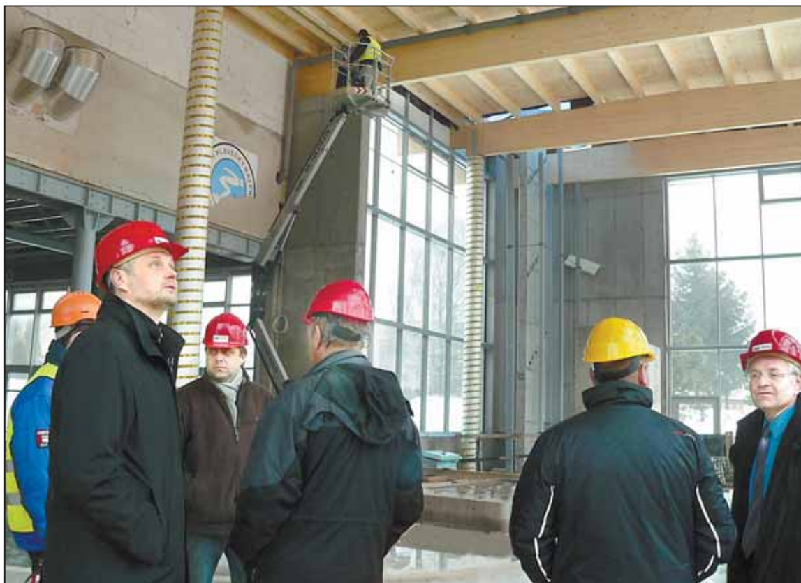
ZÁSTUPCI RADNICE při pravidelném kontrolním dni na stavbě společensko-relaxačního centra. V únoru byly napuštěny bazény z odolného betonu kvůli zkoušce těsnosti. Foto: Lenka Kopčáková
