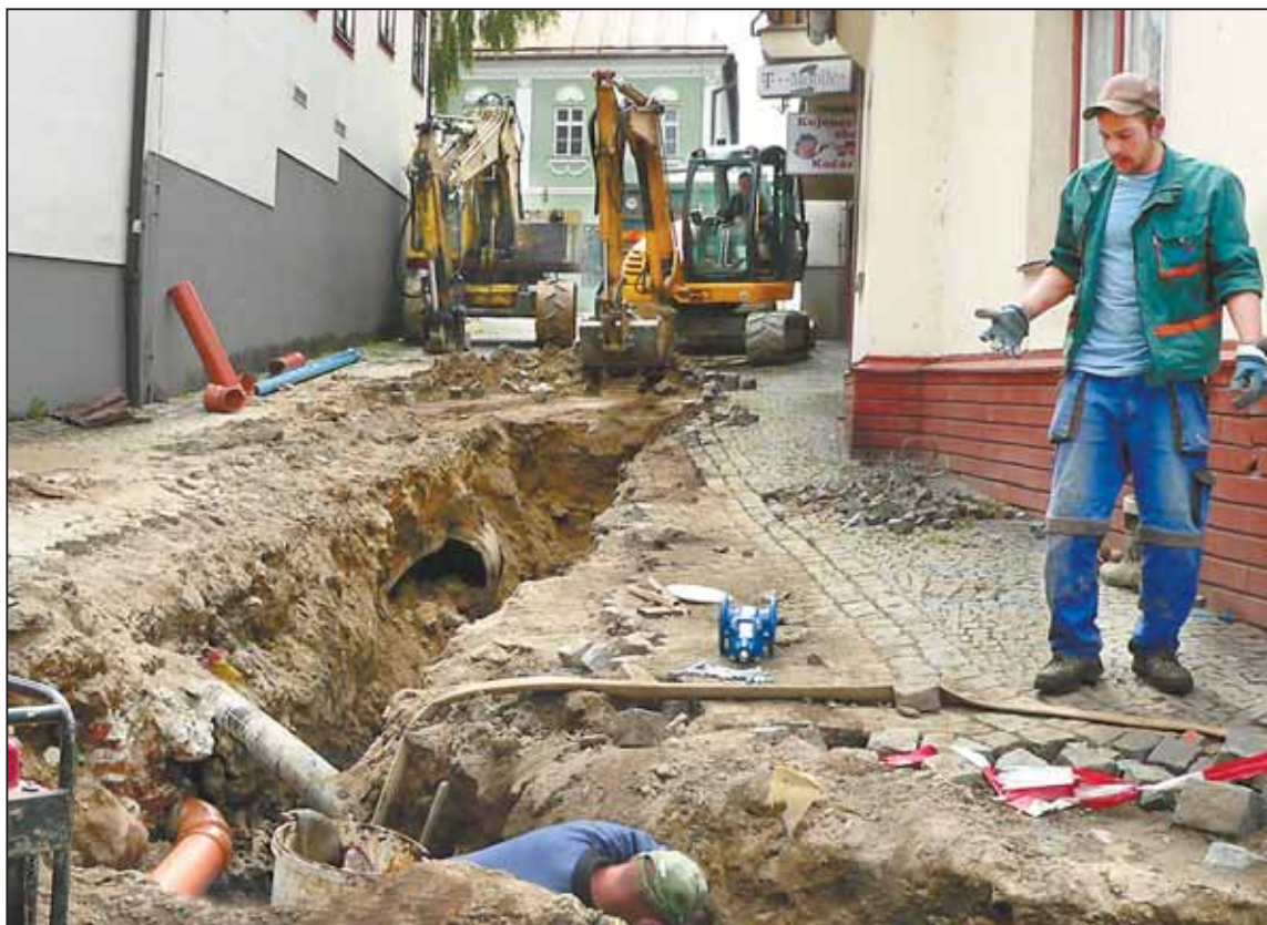
ZEMNÍ PRÁCE na vodovodu (na snímku) v Radniční ulici jsou součástí celkové rekonstrukce sítí a povrchů Havlíčkova náměstí a ulice Radniční. Na stavbě, která poběží hlavně v letní sezóně, se podílí město Žďár n. S. a Svaz vodovodů a kanalizací Žďársko.
