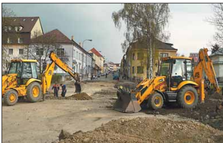
KVĚTEN 2010 a stavba kruhové křižovatky U Ivana.
