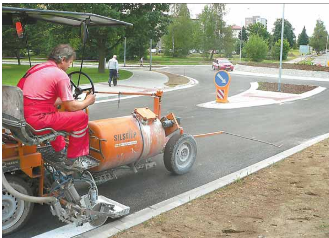
PŘESNĚ TÝDEN před spuštěním nové kruhové křižovatky probíhalo na dokončené silniční stavbě dopravní značení. Mohla tak být předána do předčasného užívání.
