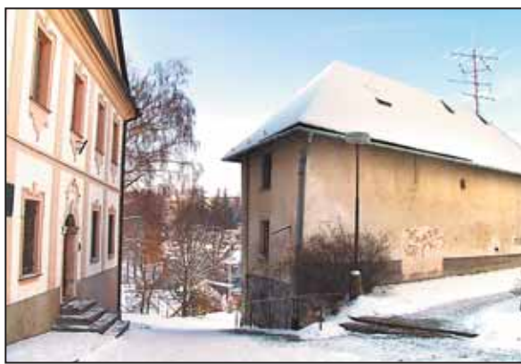
PODLE OČITÝCH svědků byly ještě koncem 19. stol. v zadní stěně Moučkovny vidět zasazené náhrobní kameny ze zrušeného hřbitova, nejspíš použité při opravě domu. Co se asi skrývá pod posprejovanou omítkou? Foto: Lenka Kopčáková
