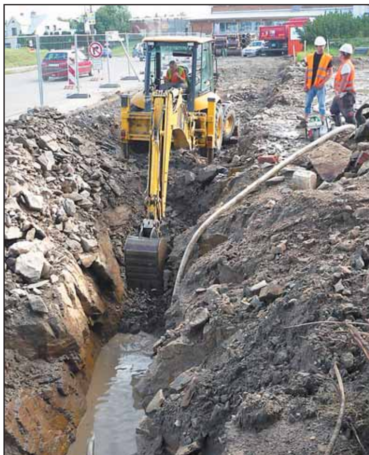
STAVEBNÍ partě při budování kruhové křižovatky u Enpeky komplikuje práci skála i červená vedra a lijáky, které zaplavovaly výkopy bahnem.
