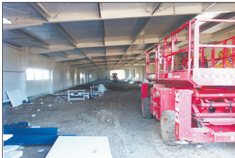
VÝSTAVBA atletického tunelu v Třebíči finišuje.
