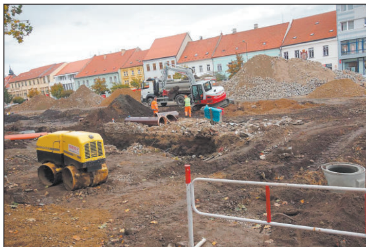
PODOBA Karlova náměstí v Třebíči během rekonstrukce.
