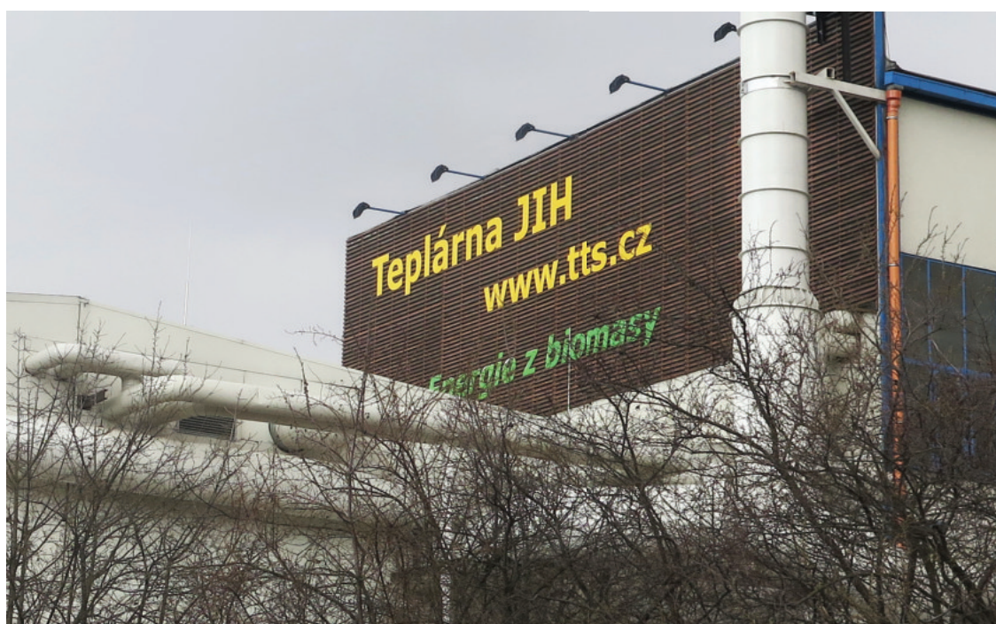
Teplárna JIH na Kubišově ulici
