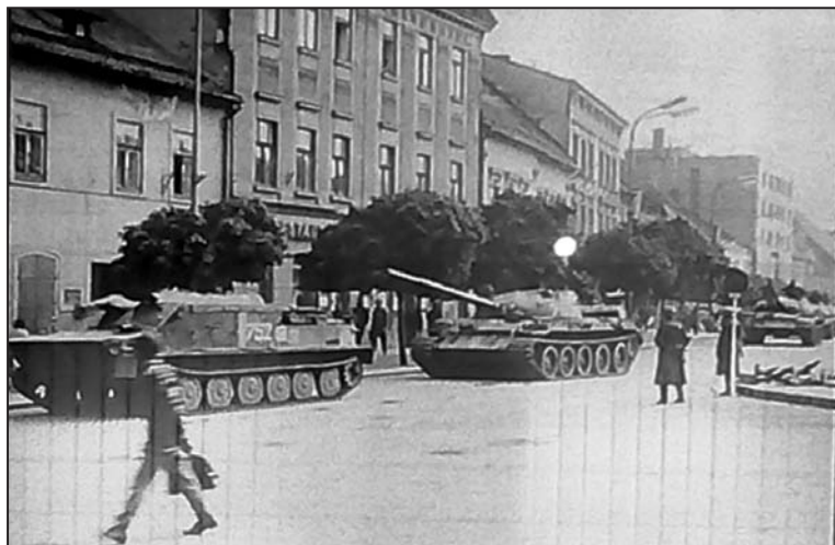
SNÍMKY Vladimíra Braunera ukazují, že sovětská armáda sem přijela dobře vyzbrojená. Foto: Antonín Zvěřina
