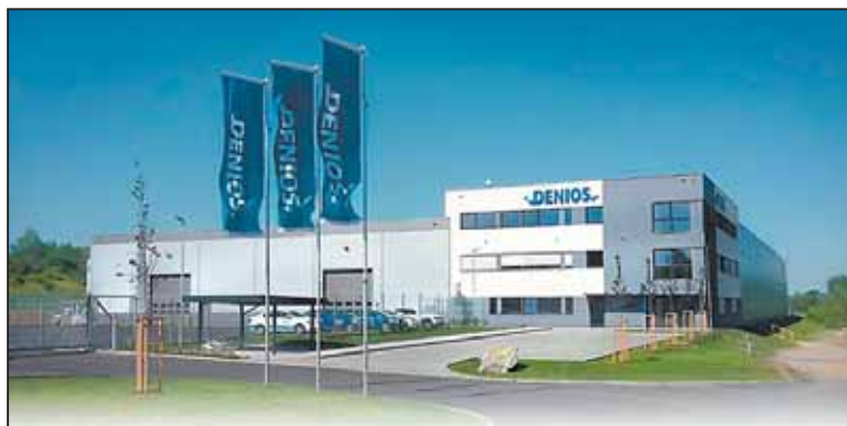
Výrobně-skladovací hala Denios patří mezi další úspěšně řízené projekty DELTA. Tato hala byla i přes komplikované povětrnostní vlivy zimního období dokončena v termínu. Architektura haly dokazuje, že i průmyslový objekt může být reprezentativní.
