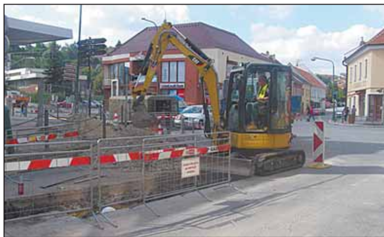
PRÁCE na rekonstrukci Komenského náměstí pokračují.
