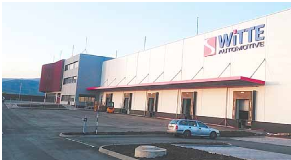
Průmyslová hala WITTE s administrativním zázemím o rozloze 22 000 m 2 v Ostrově nad Ohří
