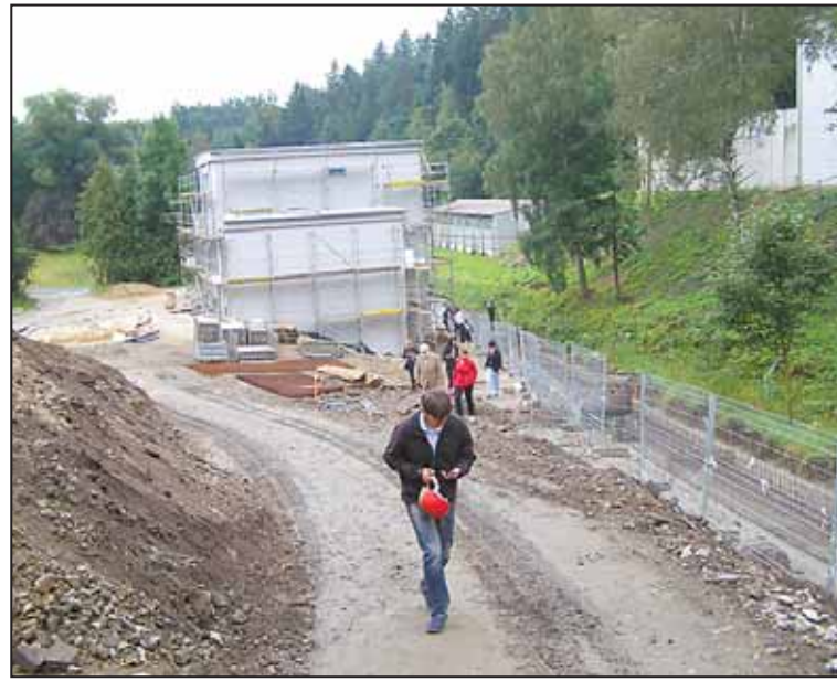
TAKÉ bývalá čistírna odpadních vod prochází rekonstrukcí, budou tam umístěna terária. Foto: Antonín Zvěřina
