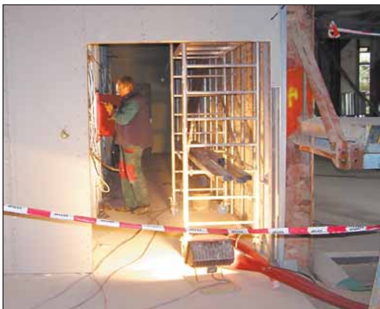
V OBJEKTU bývalé kotelny se čile pracuje, vše probíhá podle harmonogramu. Foto: Antonín Zvěřina
