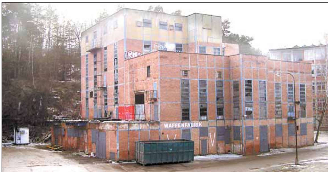
ZASTAVIT přestavbu bývalé kotelny na Dům dětí a mládeže hodlá trebičská iniciativa.
