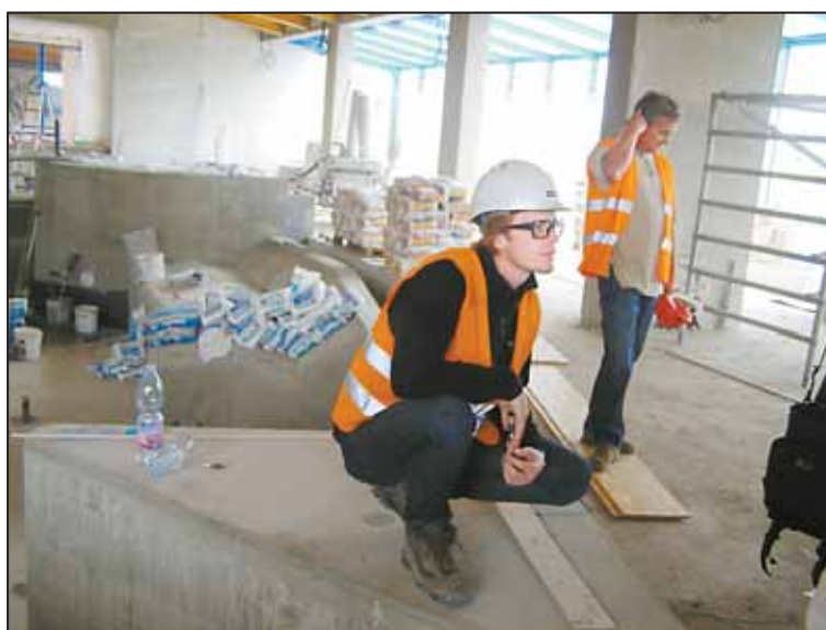
VÝSTAVBA nových atrakcí v plaveckém areálu finišuje. Foto: Antonín Zvěřina
