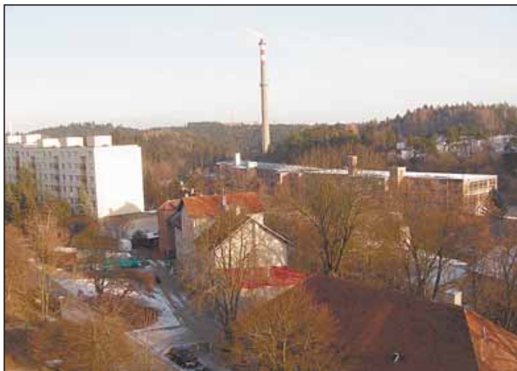
VÝSTAVBA obchvatu Třebíče je v nedohlednu.
