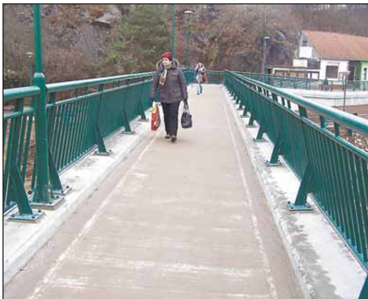
NOVÁ lávka přes řeku Jihlavu za poštu vzbudila kladné i záporné reakce.
