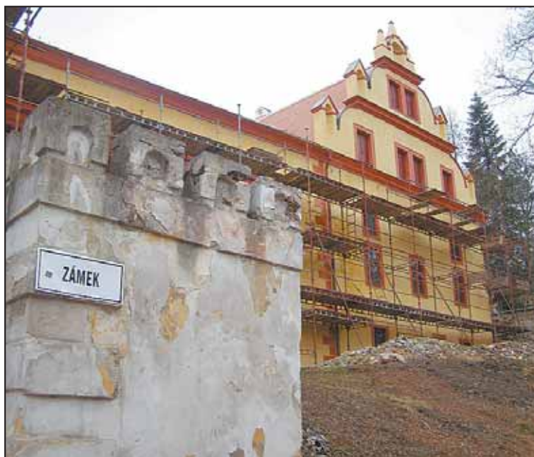
V OPRAVENÉM ZÁMECKÉM křídle bude nová výstava.
