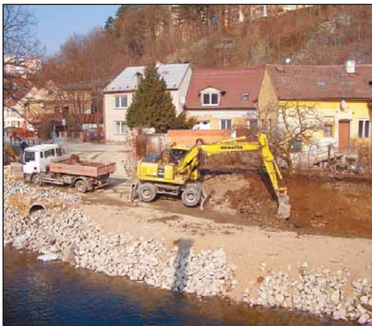
NA ŘECE JIHLAVĚ v Třebíči probíhají práce v souvislosti s protipovodňovými opatřeními. Foto: Antonín Zvěřina
