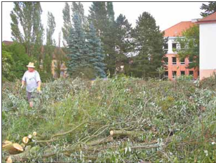
VÝSTAVBĚ nové tělocvičny musela ustoupit i zeleň. Foto: Antonín Zvěřina
